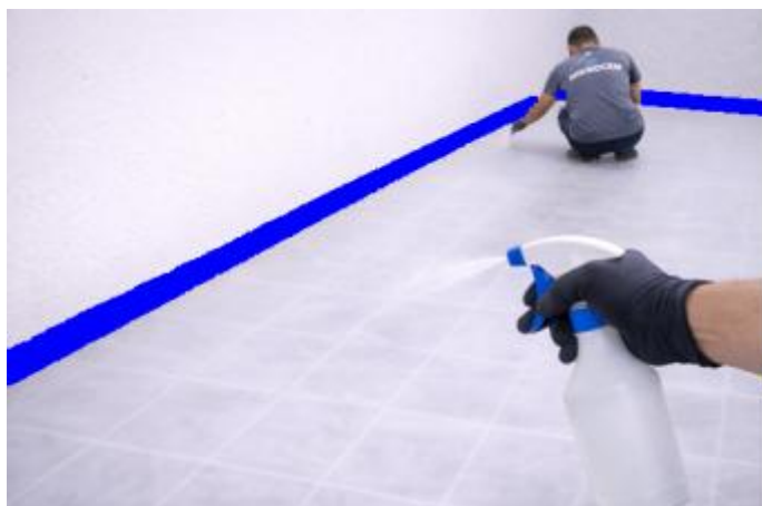
Humedezca ligeramente la superficie
