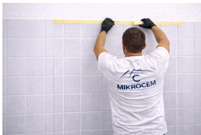
COLOCACIÓN DE MALLA EN MUROS
