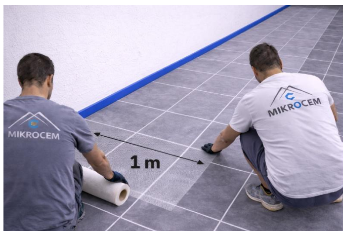
COLOCACIÓN DE MALLA EN PISOS
